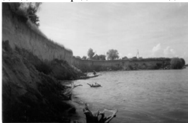
Рис. 6. Береговой обрыв на северо-восточном крыле участка, НПУ, 2005 г.
