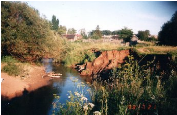
Рис. 5. Русловые процессы на р. Качке, 1998 г. Левый берег, высотой до 3-5 м, подмывается и осыпается, что угрожает находящейся на нем дороге
