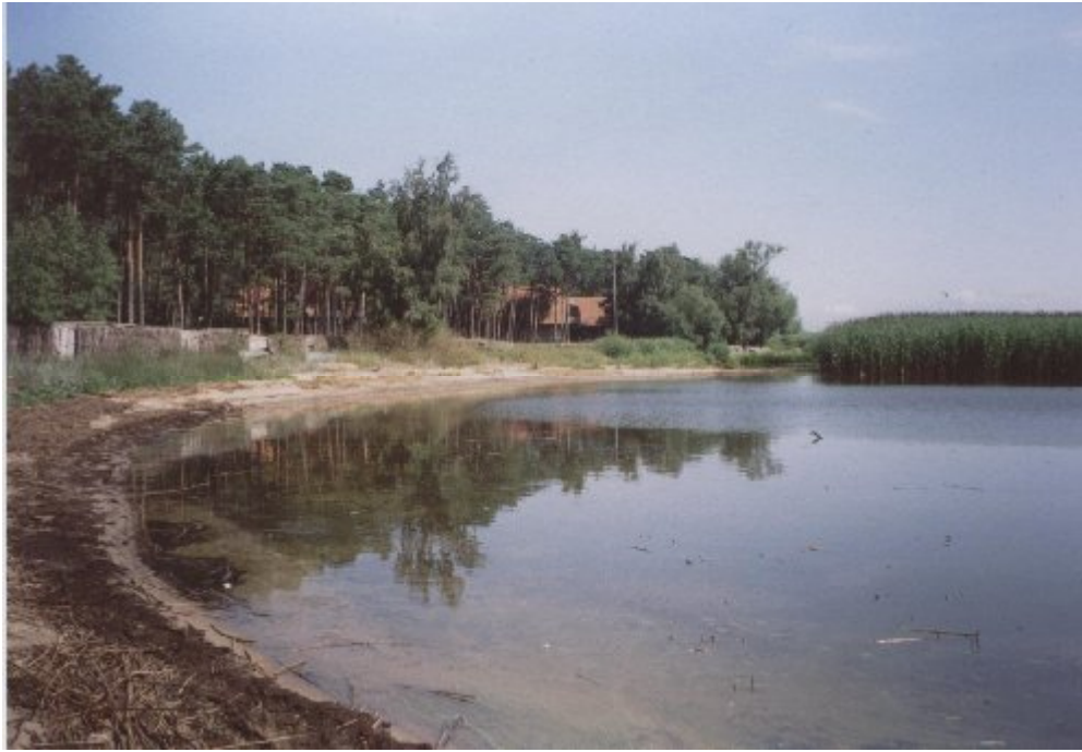
Рис.3. В разрыве полосы тростника (справа) – размыв берега и волноотбойная стенка
