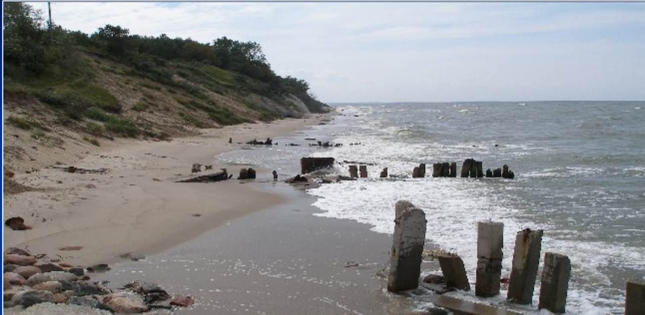
Размыв берега в районе водонасосной станции (Янтарный, июль 2007 г.)
