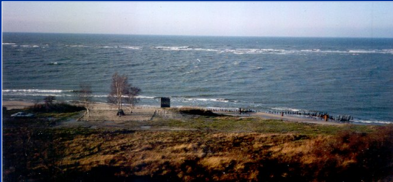
Последствия шторма в районе шахты «Анна» в декабре 1999 г. На среднем плане берегозащитная свайная стенка постройки 1891 года
