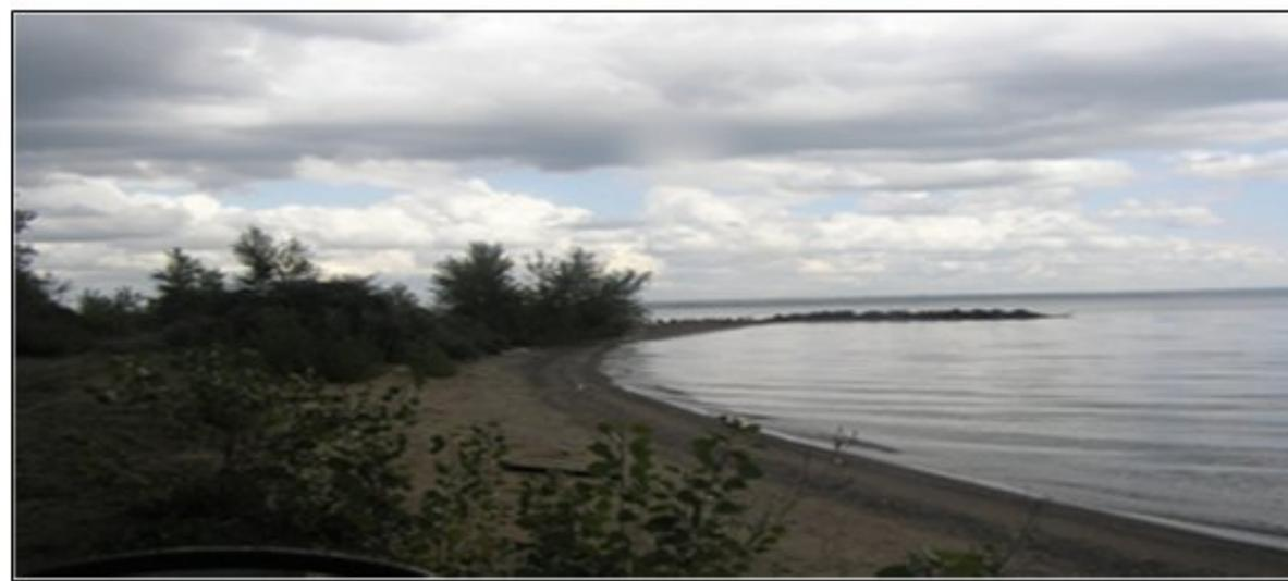
**Искусственный песчаный пляж, созданный для защиты берега после разрушения возведенной здесь ранее волноотбойной стены. Пляж огражден свайными бунами и каменно-набросным прерывистым волноломом.**
