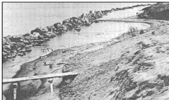
**Разрушение волноотбойных стен и каменно-набросных сооружений на Новосибирском водохранилище, 1978-1983 год**
